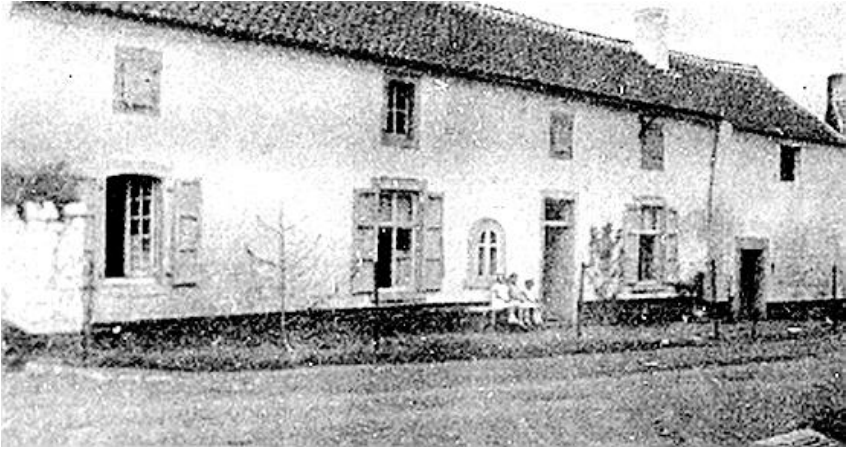
Rue d'Auvelais, la maison familiale en 1926
